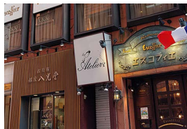
銀座西五ビル (東京都中央区)
