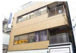
ACN東銀座ビル (東京都中央区)
